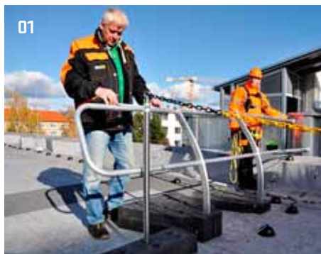
01 > Doplnění zábradlí do místa přístupu na střechu [v rámci systému TOPSAFE jsou v nabídce různé možnosti s tím, že u určitých typů není ani nutné narušit vodotěsnost střechy]
