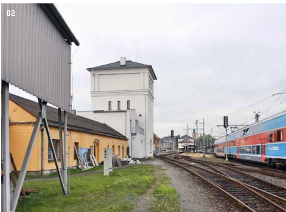
02 > Téměř čtvercový půdorys patrové budovy z režného zdiva měl v poschodí umístěn nýtované ocelové nádrže, které byly plněny vodou z přílehlé studny
