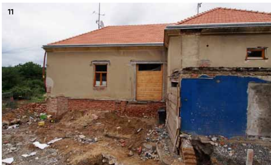
11, 12 &gt; Z průběhu stavby
