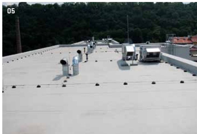
05 > Střecha bytového domu – fólie
