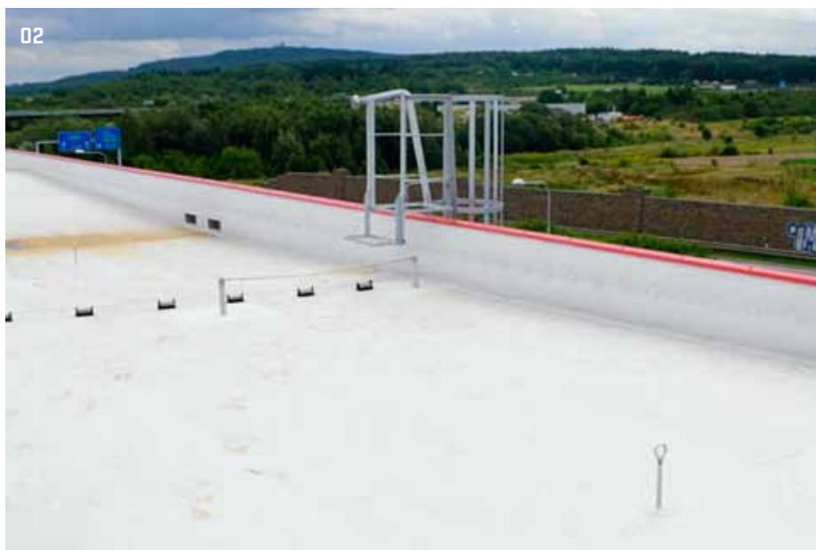
02 > Doplnění krátkého úseku nerezového lana, které umožní bezpečný přechod od žebříku přes nebezpečný okraj
