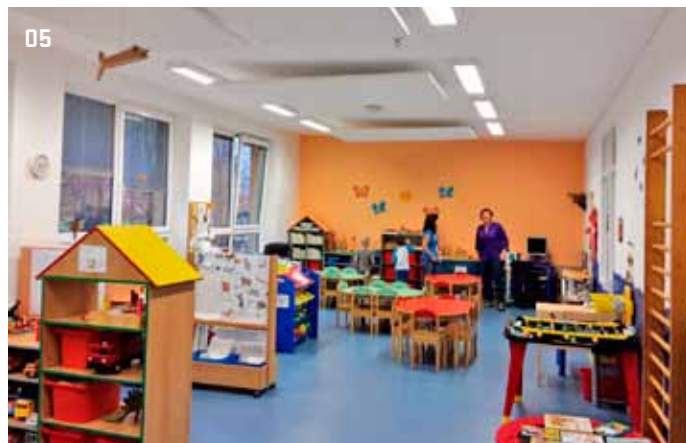
05 > Akustické řešení Ecophon Master™ SQ bylo instalováno na 35 % podlahové plochy
