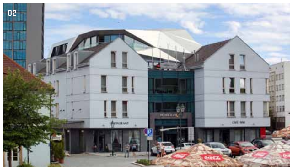
02 > Nástavba vznikla nad hotelem, který je také dílem ateliéru Len+K architekti a záměrně byl před deseti lety vytvořen jako tradiční stavba v centru města (Stavba roku Plzeňského kraje 2006)
