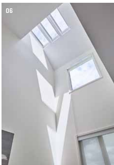
06 &gt; Okna mají trojskla, jejich umístění maximalizuje křížové větrání i komínový efekt
