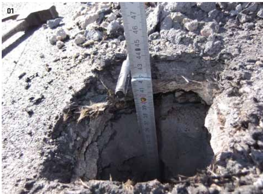
01 &gt; Sonda do střechy
