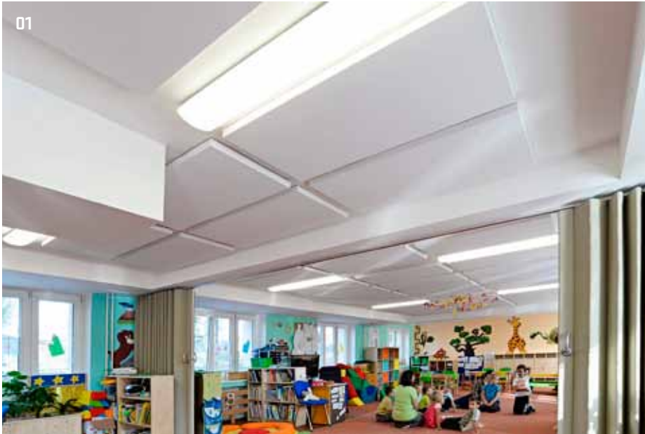
01 > Do tohoto prostoru se instaloval systém Ecophon AdvantageTM A po celé ploše stropu
