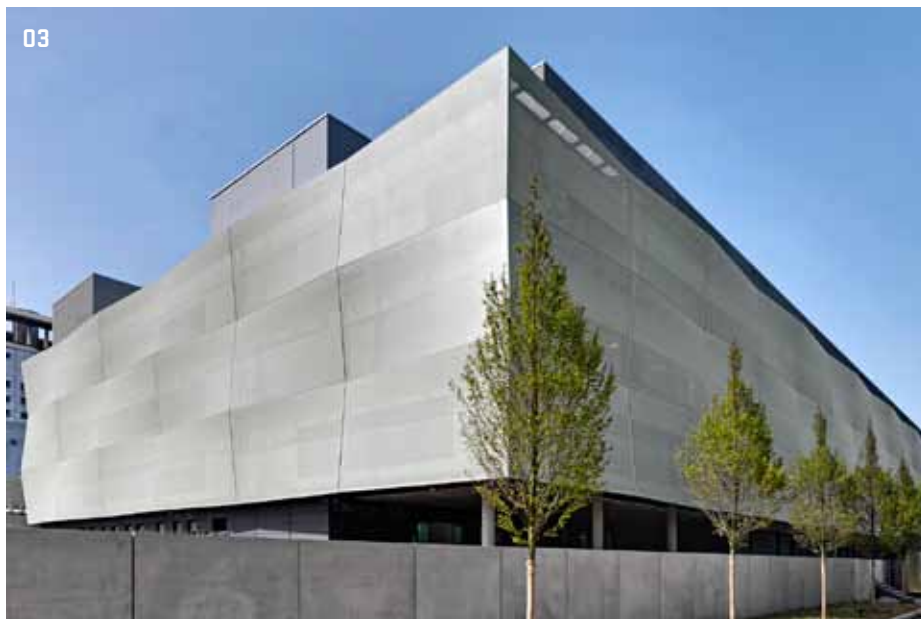
03 > 3D vzhled textilní fasády FACID na budově chirurgického centra v Mnichově (Großhadern)
