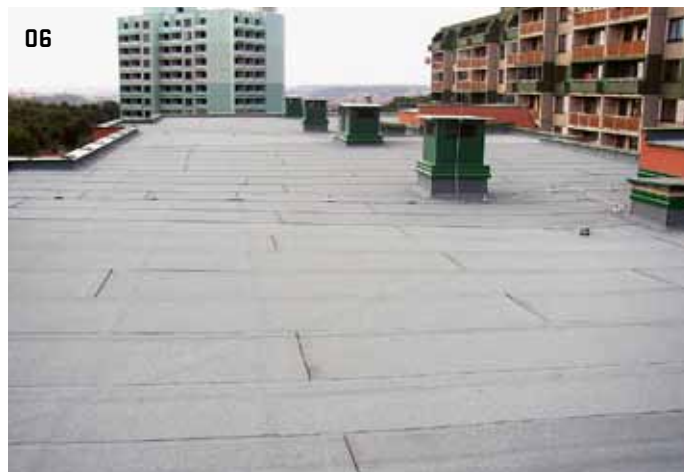
06 > Střecha bytového domu – asfaltové pásy
