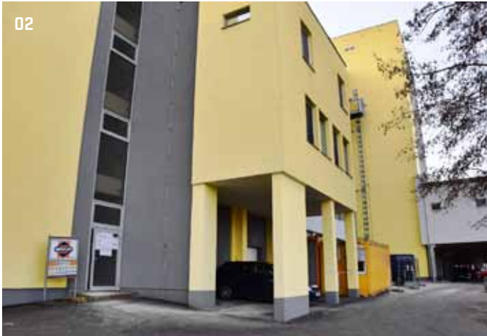
02 &gt; Sokolov – nemocnice, lůžkové oddělení chirurgie
