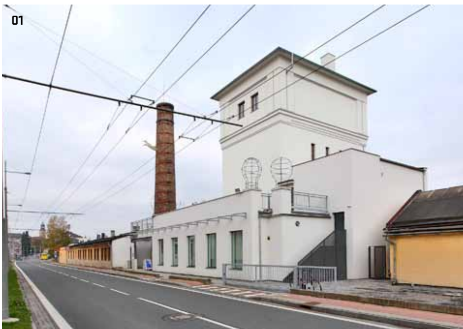
01 &gt; Vodárenská věž Opava
