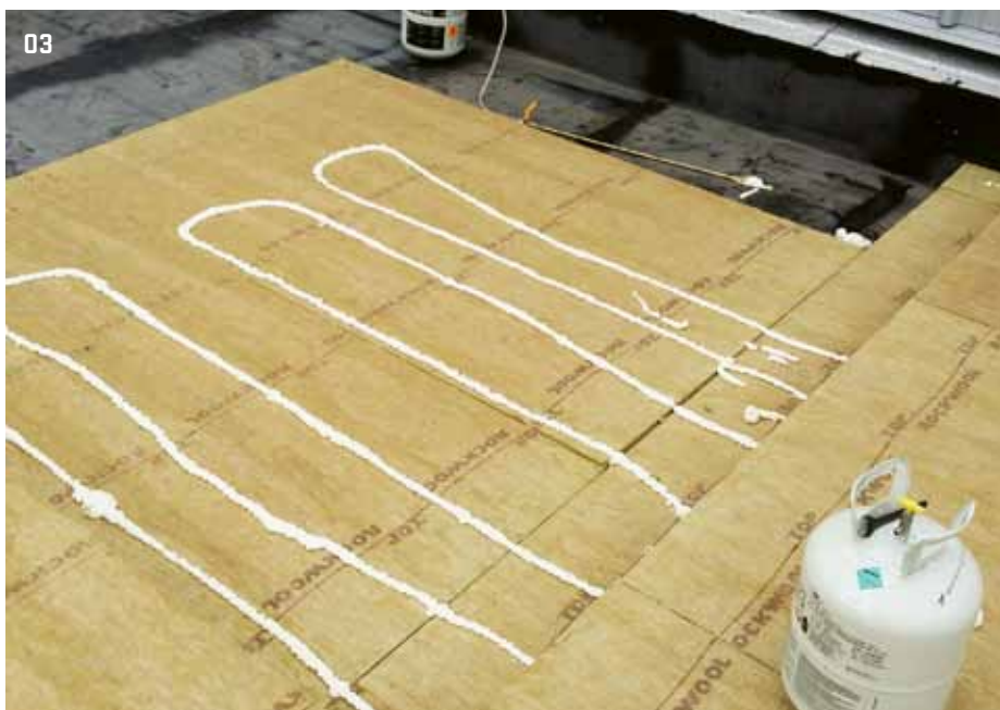
03 > Lepení tepelné izolace
